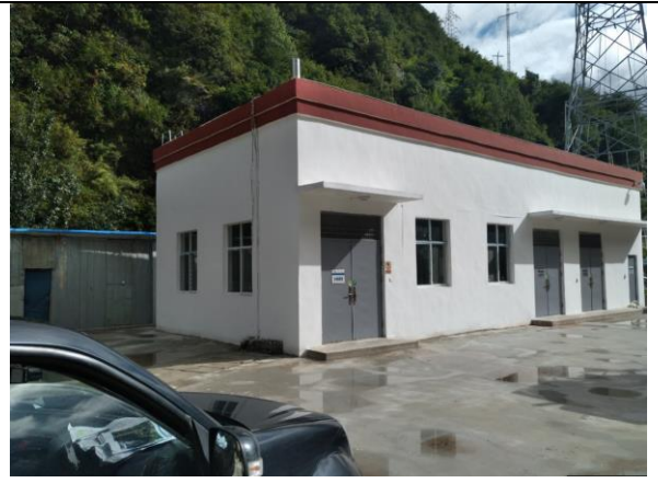
其他施工场地（牵力场，已移交）情况
