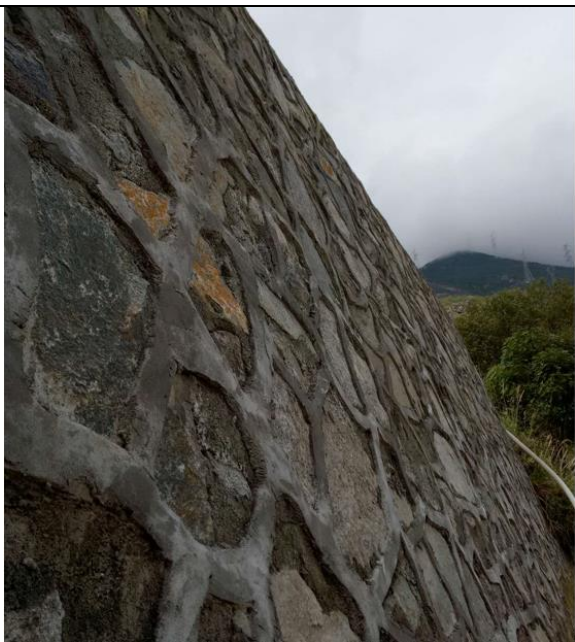
浆砌石堡坎及排水沟 (N27)
