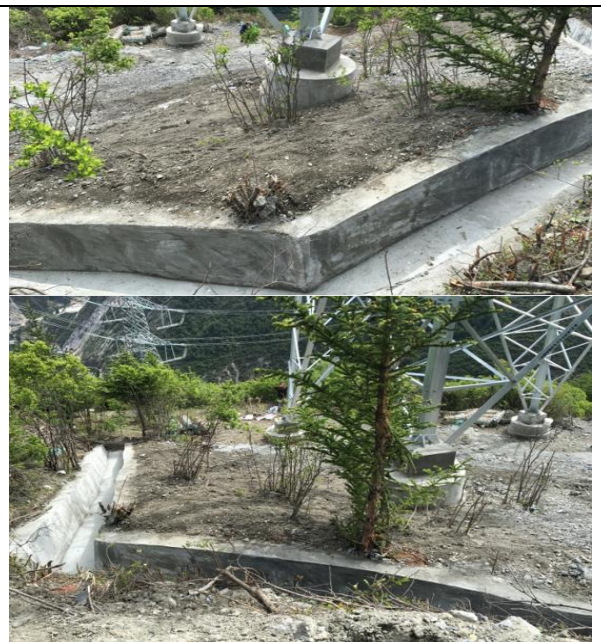
浆砌石堡坎及排水沟 (N27)
